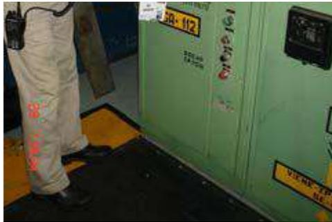
En la instalación de juntas ciegas para intervenir un equipo dinámico o estático, el **ejecutor** (operario tubero e instrumentista) coloca su **candado gris y etiqueta** en el interruptor, válvula del equipo, válvulas de seguridad a intervenir, antes de instalar las juntas ciegas.
