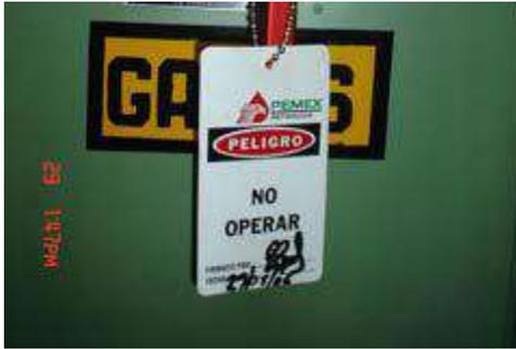
El operador responsable **identifica el equipo** en el centro de control de motores (CCM) y/o en la subestación eléctrica correspondiente, y lo desenergiza, instala en el porta candado, el primer **candado color rojo**, con la etiqueta de seguridad (Peligro no Operar) en la puerta del Interruptor o arrancador.
